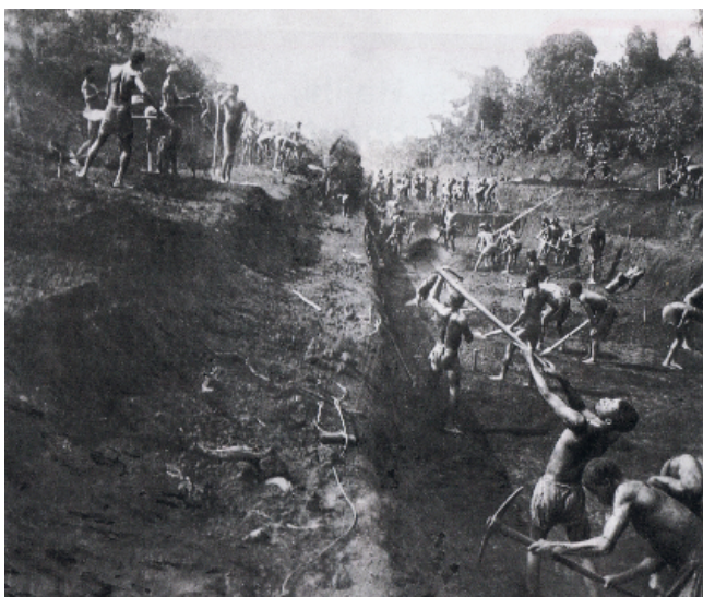
Document 4 : travailleurs sur le chantier de construction du chemin de fer Congo Océan :
