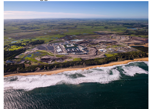
Document 6 : Usine de dessalement de Wonthaggi à Melbourne
